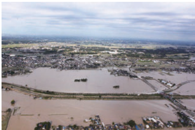
茨城県常総市上空からの被害状況 (平成27年9月14日) (茨城県提供)
